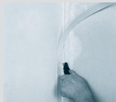
6. Nakon sušenja treba odseći višak razdelne trake
