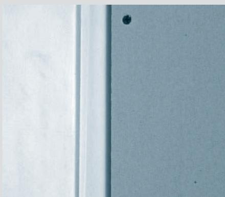
4. Knauf ploče se montiraju sa razmakom od 5 mm prema traci
