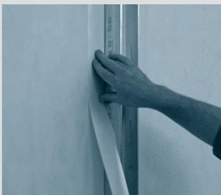
2. Alternativno se Trenn-Fix može lepiti na građevinski element na mestu spoja, nakon montaže profila
