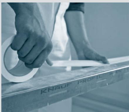
1. Samolepljiva Trenn-Fix traka se lepi za CW/UW ili UD profil
